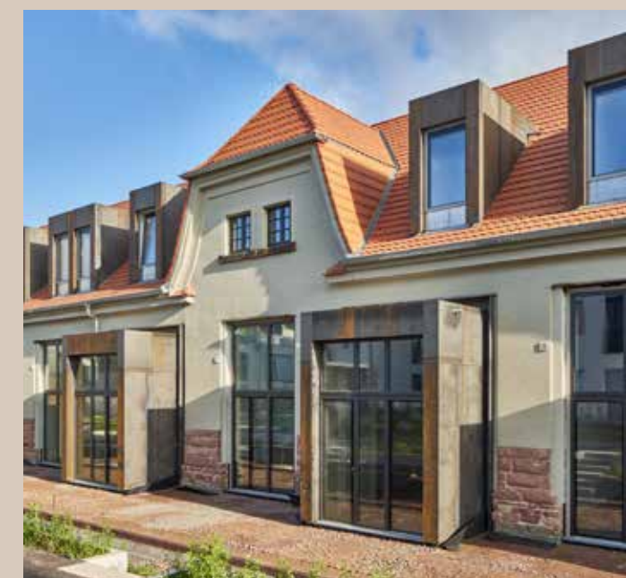
Riqualificare anziché costruire ex novo. L'ambiziosa ristrutturazione di un edificio sotto tutela, con numerose soluzioni speciali per le finestre. Per visualizzare la realizzazione completa: finstral.com/landauholch
