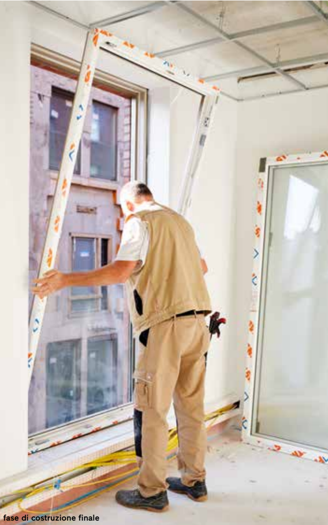
fase di costruzione finale
