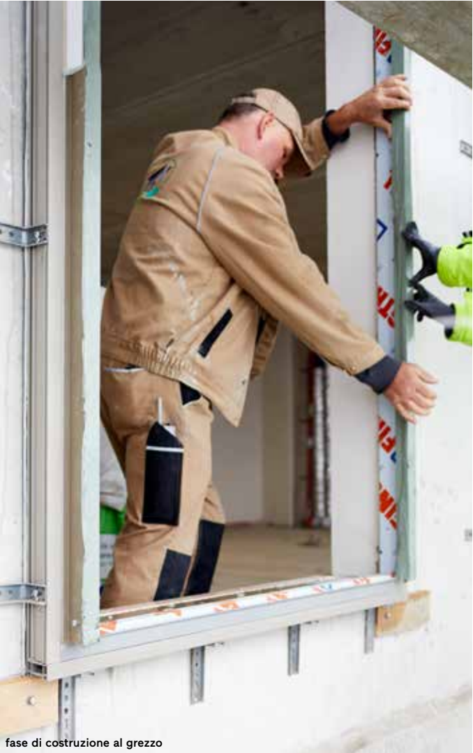
fase di costruzione al grezzo
